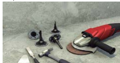
6. Retirar por medios mecánicos las boquillas y resina de sello.
