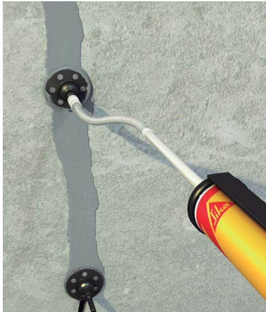
3. Coloque la resina de sello en la fisura.
