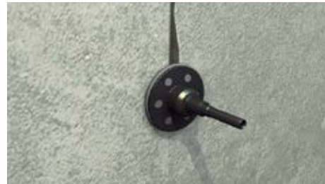
3. Coloque la resina de sello en la fisura.
