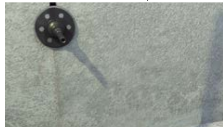
5. Empiece a inyectar por las boquillas. Dejar curar.
