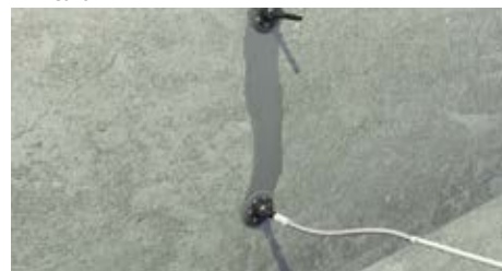
6. Retirar por medios mecánicos las boquillas y resina de sello.
