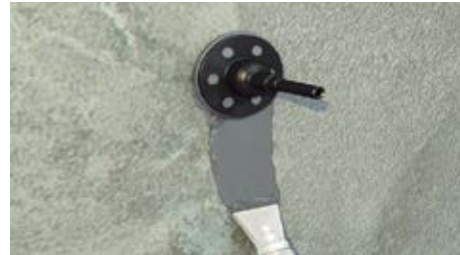
4. Inserte la manguera de inyección en el cartucho de la resina de inyección.
